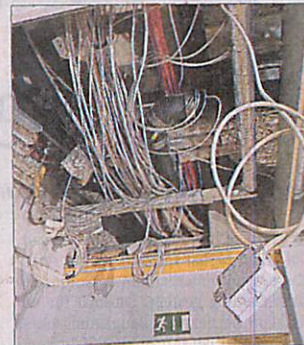
Einige Jahrzehnte hat die Elektrik auf dem Buckel. Sie wird komplett ausgetauscht.
